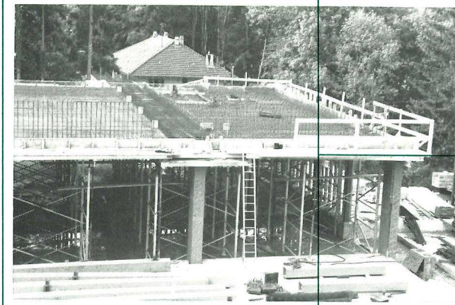
Schalung und Armierung für die Zwi- schengeschosdecke Teil Nord (Sep- tember 1985)
