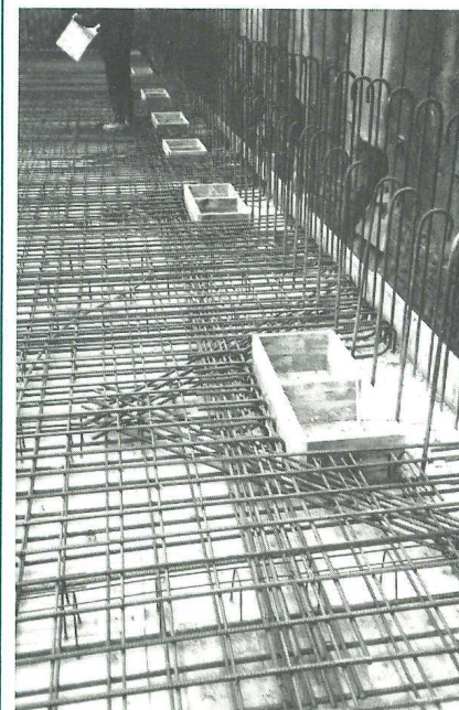
Vorspannkabel für die Parkplatzplatte vor dem Einbetonieren (Juni 1985)
