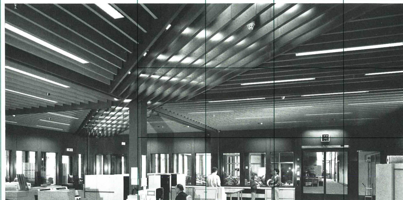
Decke Maschinensaal B und Wände Dieselraum: Verwendung von Schallabsorbierenden Materialien zur Raumakustischen Konditionierung.
